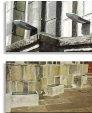
Abaixo detalhes das instalações dos projetores de LED RGB. À direita, arquitetura da fachada frontal destacada pela iluminação.
